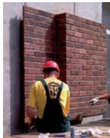
Монтаж навесной вентсистемы «ДИАТ»
